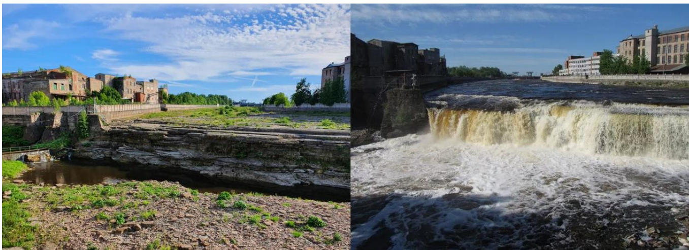
Рисунок 2 – Пересохшее русло реки Нарва и Нарвский водопад во время сброса воды через плотину Нарвской гидроэлектростанции
